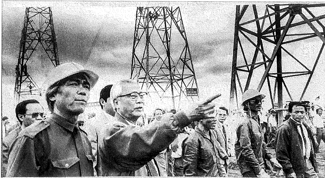
Thủ tướng Võ Văn Kiệt chỉ đạo thi công đường dây 500kv Bắc - Nam. Ảnh tư liệu.
