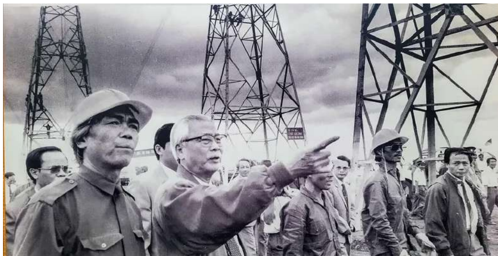
Thủ tướng Võ Văn Kiệt chỉ đạo thi công đường dây 500kv Bắc - Nam. Ảnh tư liệu
